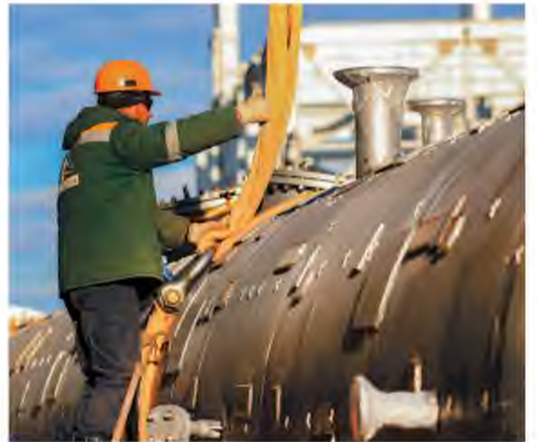
Идут такелажные работы
