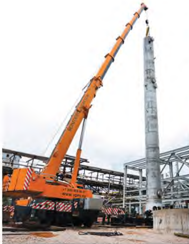
Колонна дистилляции предназначена для выведения из продукта аммиака и углекислого газа
