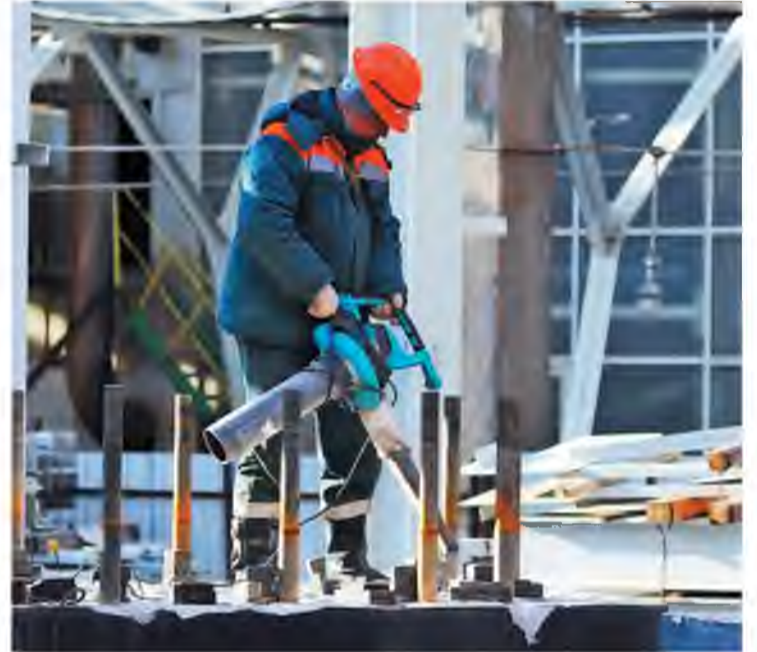
Чтобы точно установить колонну, поверхность фундамента проходит специальную подготовку
